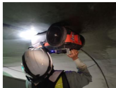
図7 レーダー探査状況
