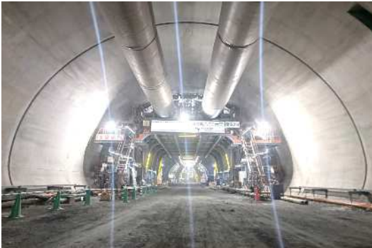
写真－2 覆工コンクリートの仕上がり
