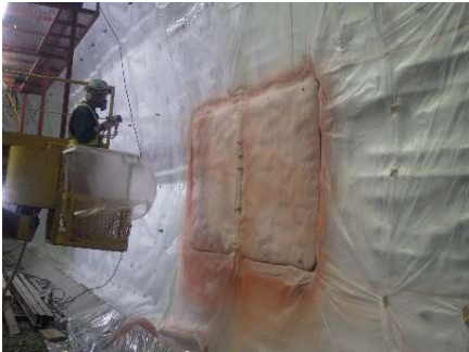
写真-1 試験施工 (2018.2)
