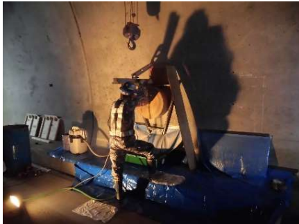
写真-2 覆工コア抜き (2019.7)
