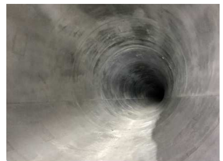
写真-3 コンクリート打設完了部
