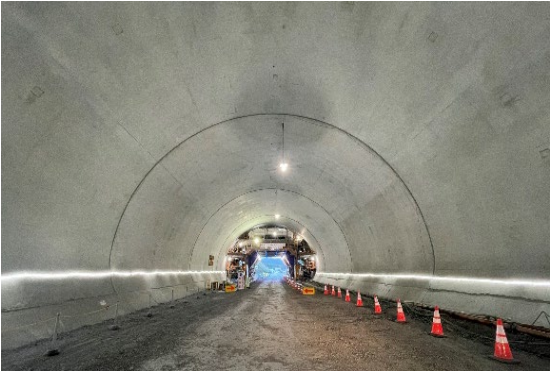
写真-1 覆工コンクリートの仕上がり状況
