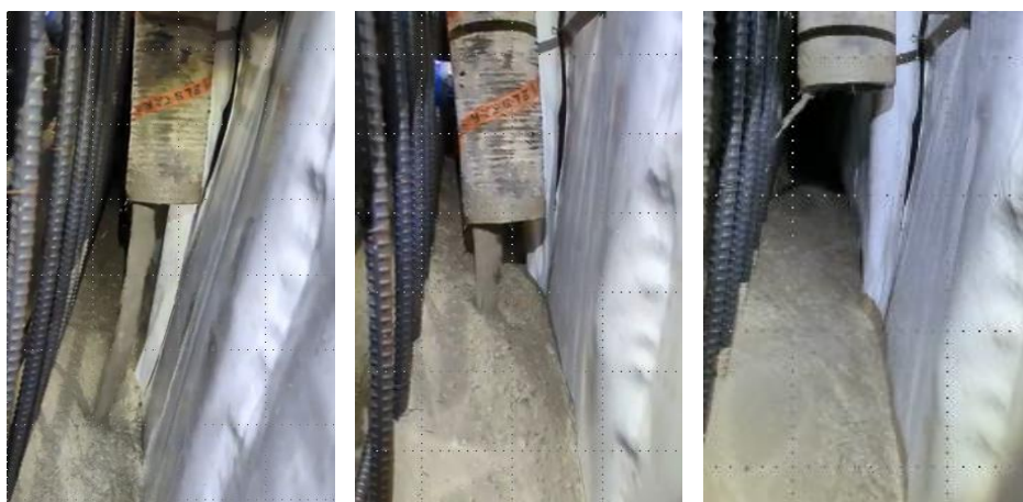
図-6 本システムでの打設状況
