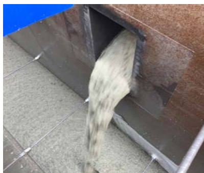
図-6 打設口より低い位置における打設状況
