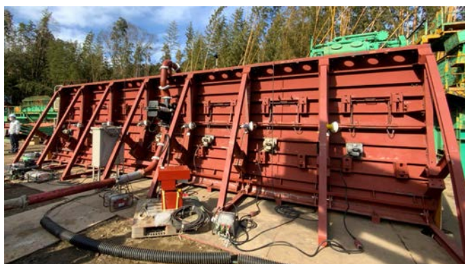
図-5 模擬型枠を用いた打設実験状況
