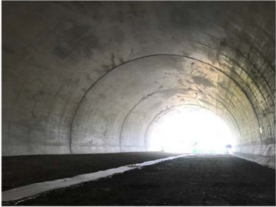
写真-3 脱型後の仕上がり状況
