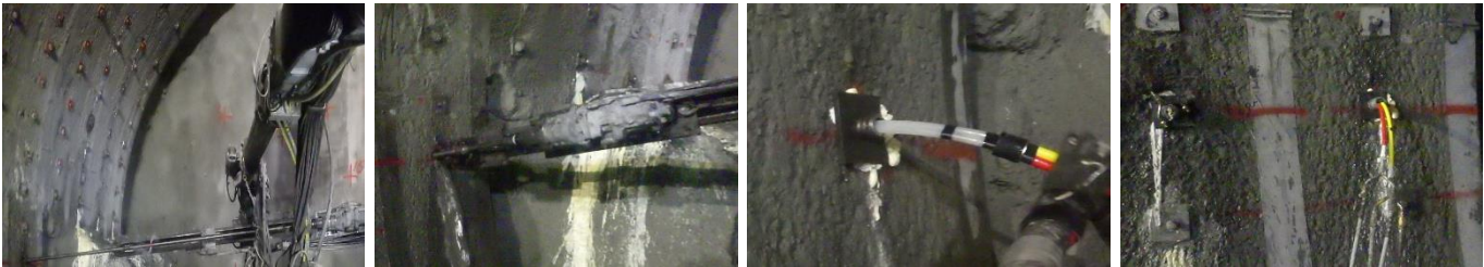
写真-2 施工状況全景 写真-3 打設状況 写真-4 注入チューブ建込状況 写真-5 注入状況
