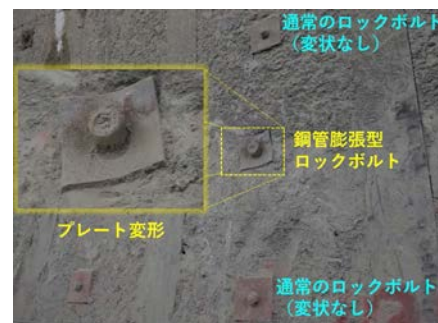
図-3 施工 1 日後のプレート状況
