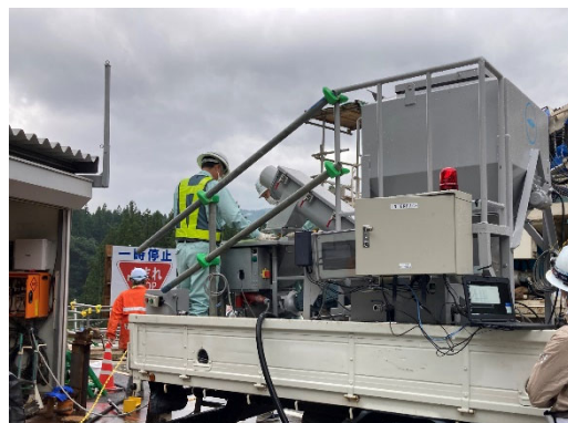
図-2 モルタルディレクタ設置状況
