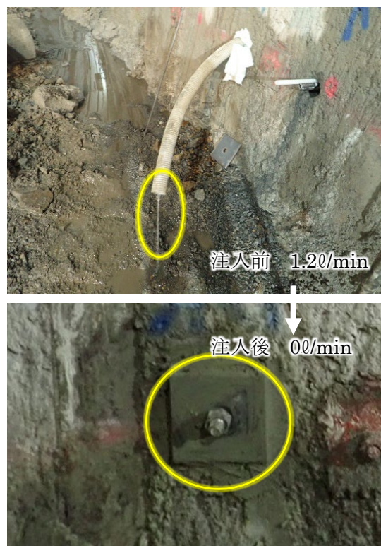
写真-3 注入前後の湧水量
