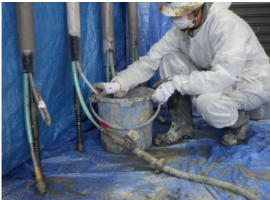
写真-2 室内充填性試験
