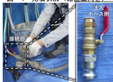
図-5 注入ホースとパッカーの接続部
