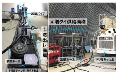
写真-3 自動装薬システム構成
