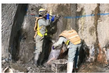
写真-1 一般的な装薬状況
