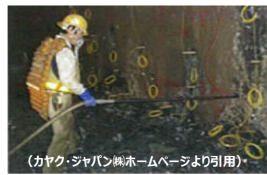
写真-2 遠隔機械装填状況
