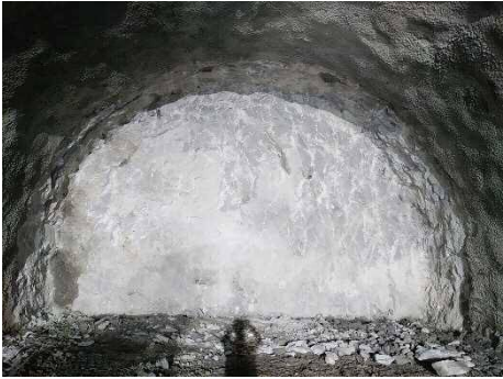
写真-2 切羽状況
