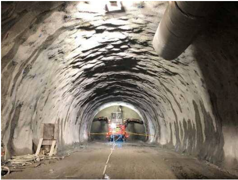
写真-1 現場状況
