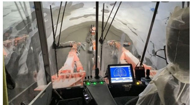
写真-2 無人での自動削孔状況（操縦席より）
