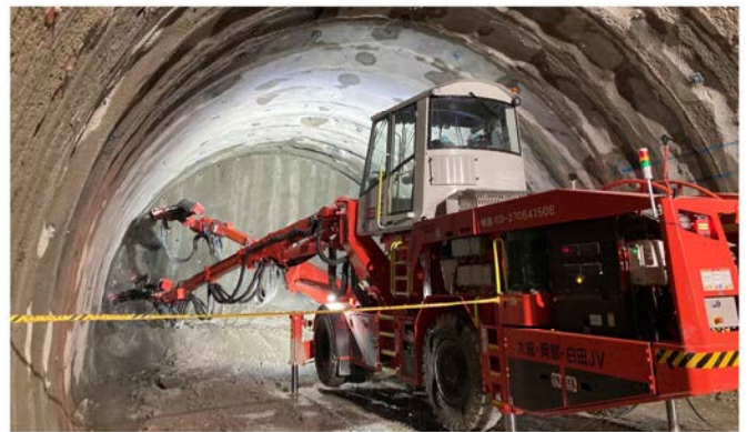
写真-1 フルオートコンピュータジャンボによる削孔
