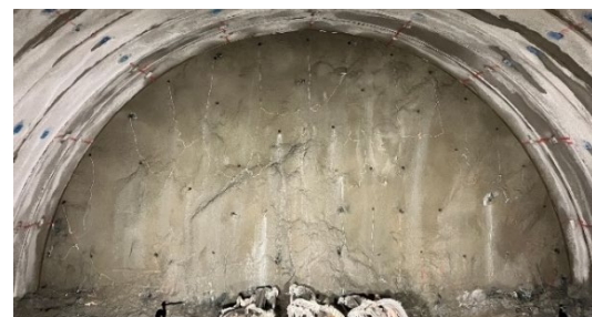
図6 装薬完了状況
