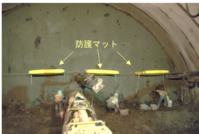
図-5 防護マットを設置して行う従来の切羽下部での装薬作業
