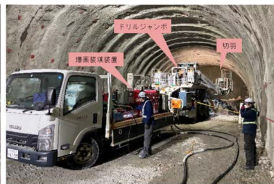
図-8：実トンネルでの実証試験
