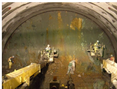
図-1 人力による装薬状況
