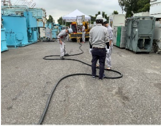
図-5 ホース曲げ圧送状況
