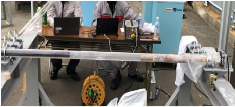
図-4 爆薬圧送状況
