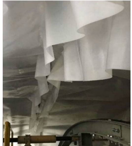
写真1 3次的に波をうったような溶着ライン
