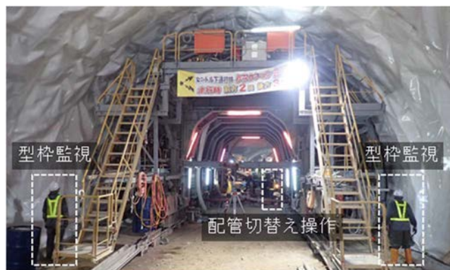
図-3 新工法での覆工打込み
