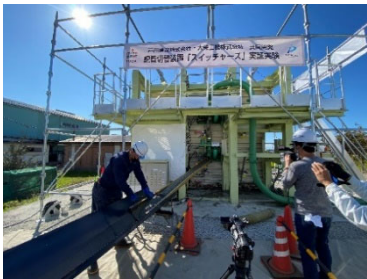
写真-4 実証試験状況
