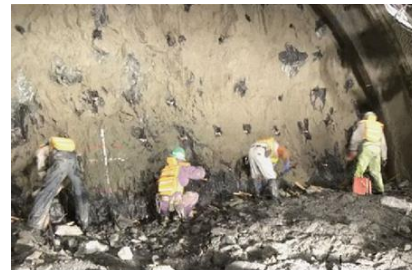
写真-1 人力による装填作業
