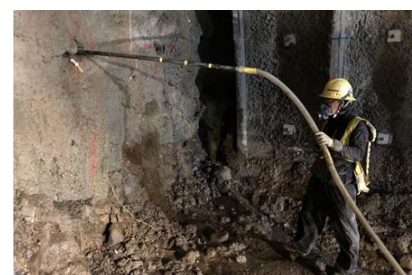
写真-2 遠隔装填による装填作業
