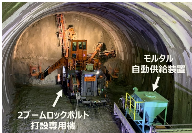
図1 ロックボルト遠隔施工システム
