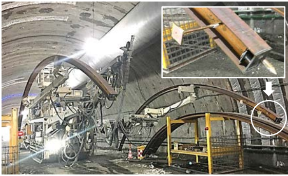
写真-2 転倒防止アンカーボルトの取付け状況
