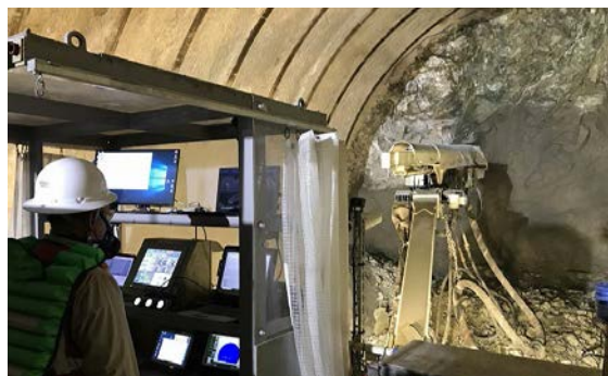
写真-1 自動吹付けの実証実験
