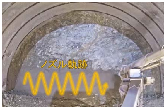
図-3 切羽の吹付け
