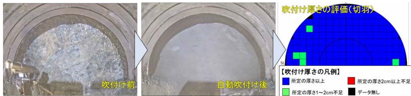
図-6 自動吹付けによる一次吹きの実験結果（一例）
