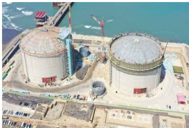
写真-1 現場全景
