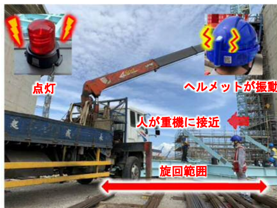
写真-3 重機の検知アラーム
