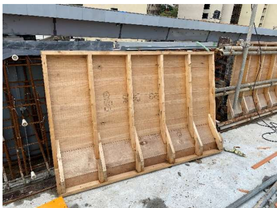
図-5 高欄コンクリート型枠
