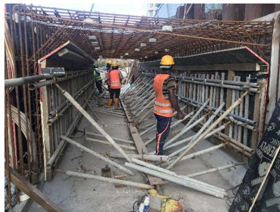
図-2 型枠作業風景
