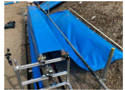
写真-1 屋外張力試験状況
