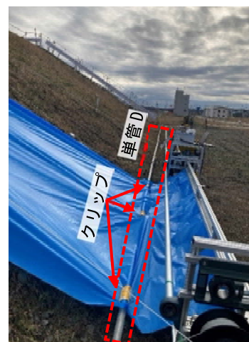
写真-4 BS 固定状況（法尻部）
