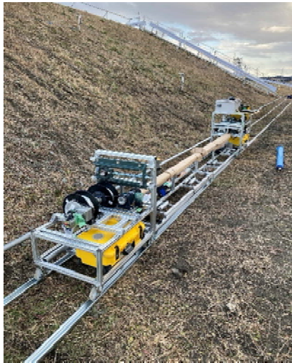
写真-1 自動施工機械外観
