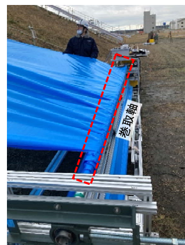
写真-5 BS 巻取状況
