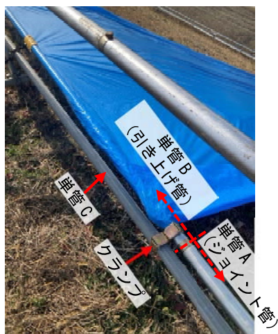
写真-3 BS 固定状況（法肩部）
