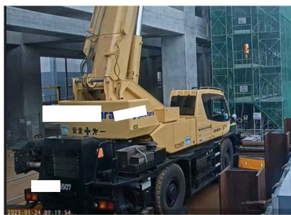
図－6 仮設材のクレーン揚重と設置状況 （ケース②）
