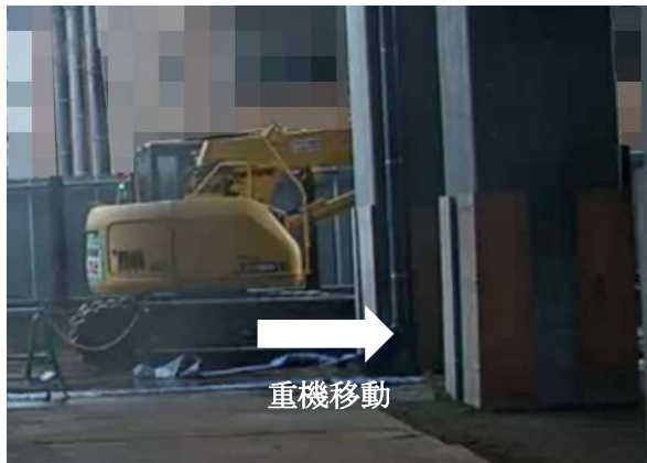
図－5 重機移動状況 （ケース①）
