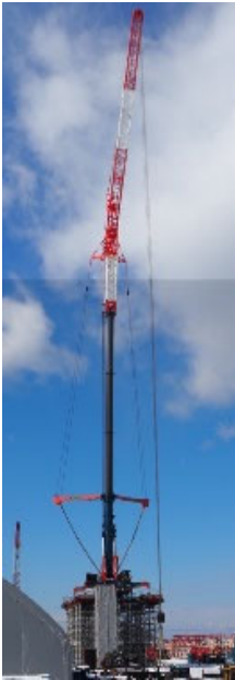
写真-1 嵩上げ完了
