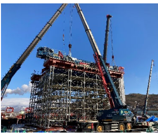
写真-2 クレーン組立状況
