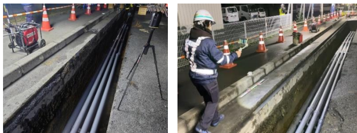
図4 左：現場状況，右：計測状況
