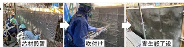
写真-1 吹付け埋設型枠の製作状況
