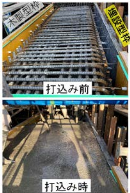
写真－2 打込み状況
