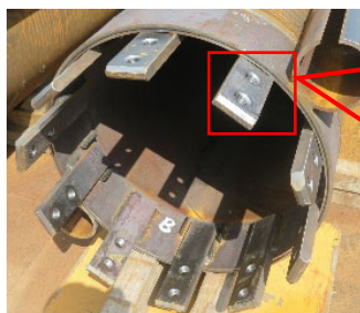
写真-8 止水ゴム設置状況
