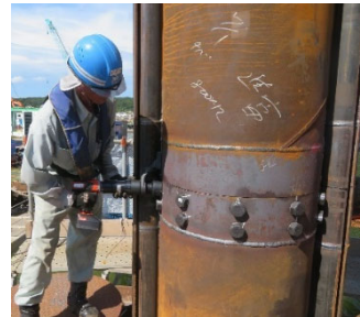
写真-7 上杭建込完了
