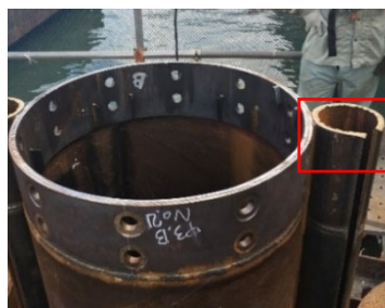
写真-9 ブチルテープ設置状況
