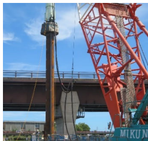
写真-4 下杭打設状況
