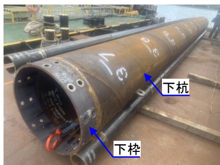
写真-1 下杭、下杵
