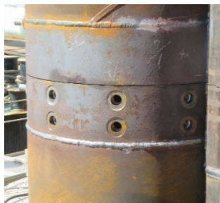
写真-6 上杭建込完了
