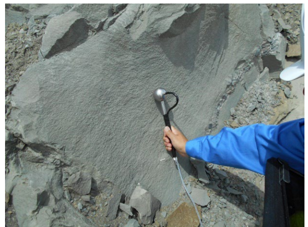
図-2 打球探査の状況
