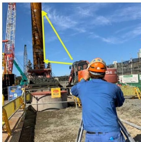
写真-1 トランシットによる鉛直管理
