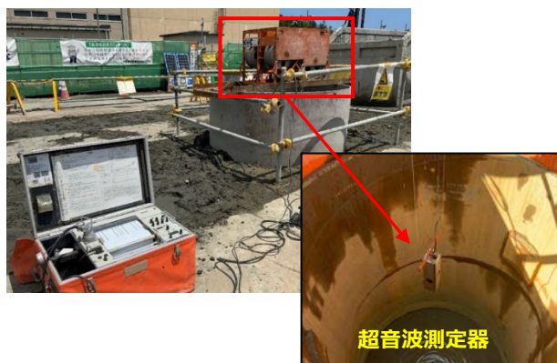
写真-4 超音波測定による鉛直精度確認
