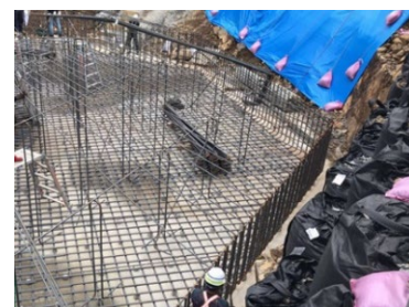
図-4 鉄筋馬筋架台
