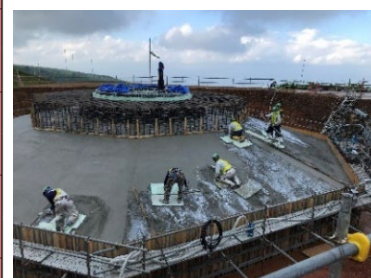
図-7 仕上げ作業状況
