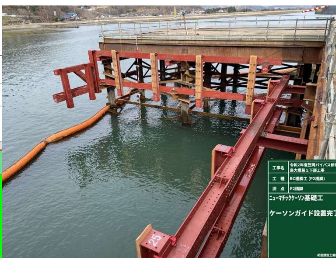
写真-1 ケーソンガイド設置状況
