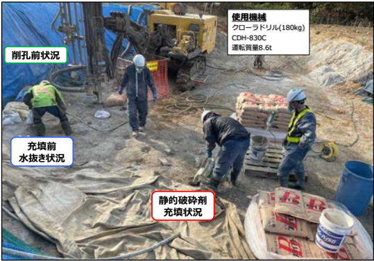
写真 1 施工状況写真
