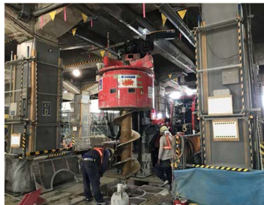
写真-1 施工状況
