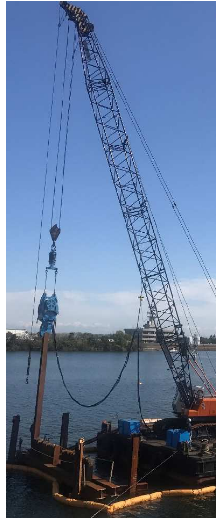
写-3 H 鋼杭打設状況
