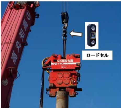
図-3 試験施工荷重計測状況図
