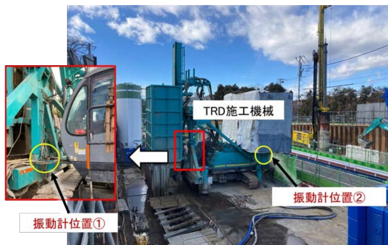
図-4 TRD 施工機械への取り付け位置
