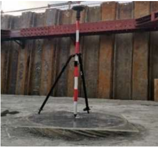
図 2 杭芯の測位状況
