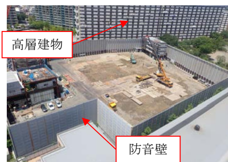
写真-1 現場状況
