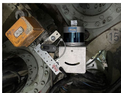
写真-1 LiDAR 設置状況
