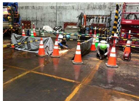
図-4 鋼板敷設状況
