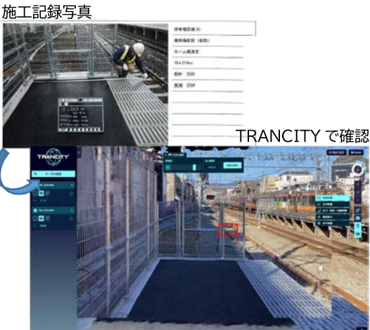
図-4 従前・従後の施工記録
